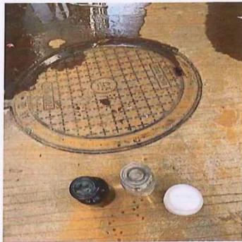
生活污水排放口
