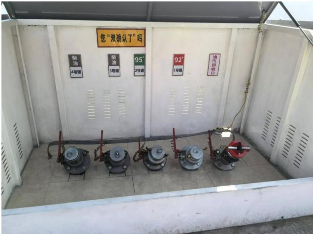
图 4.1-3 油气回收装置
