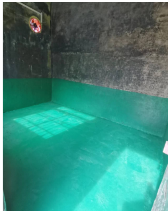
危废仓库内部
