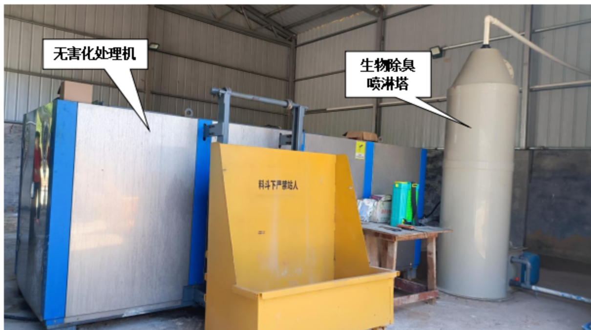
图4.1-9 无害化处理机废气治理设施
