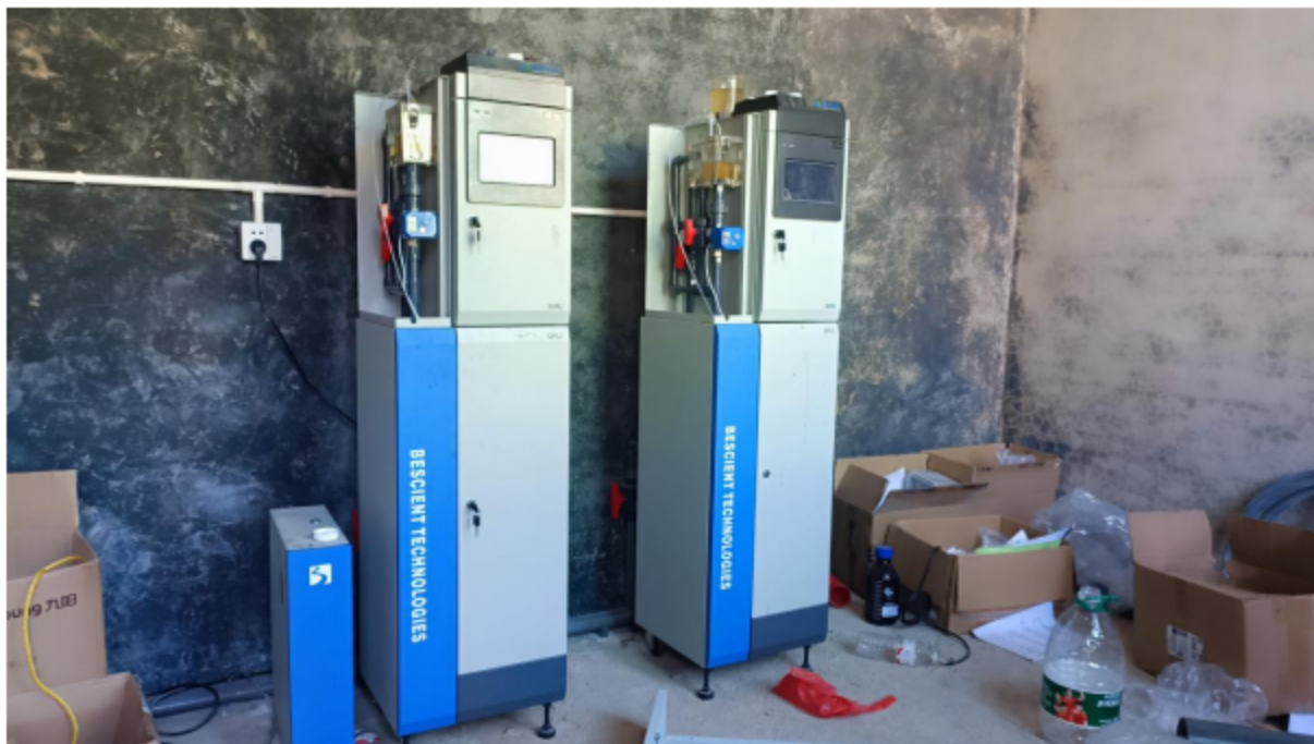
图4.2-3 废水在线监测设备
