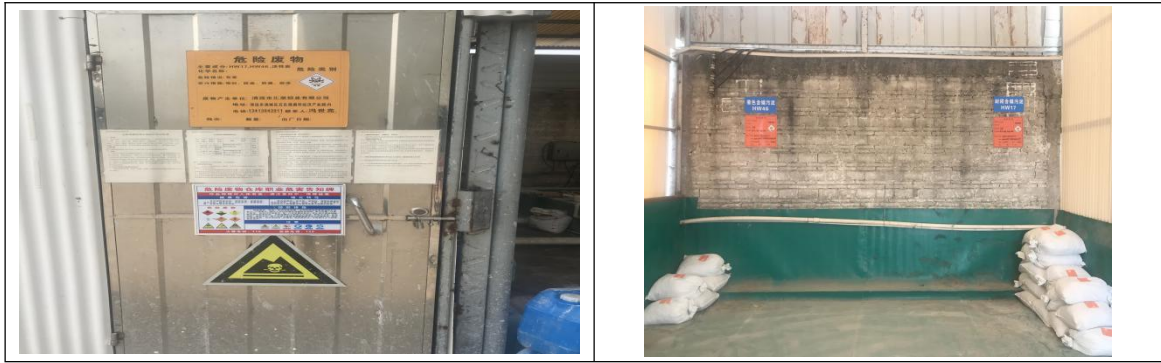
图 4.1-3 项目二期工程依托的危废仓库
