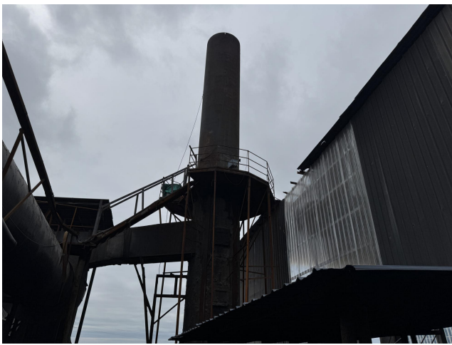
熔炼/炒灰废气排放口
