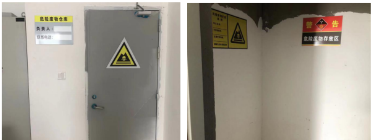
图4.2-2 危物暂存仓库
