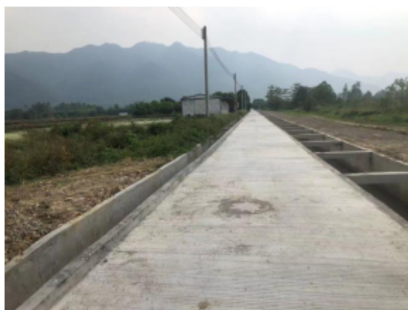
铺设好的污水管道
