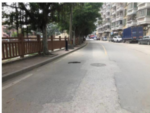
铺设好的污水管道
