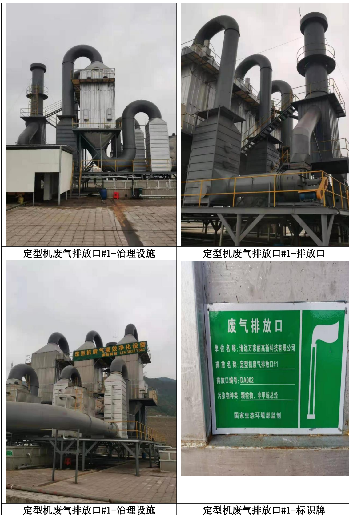
图4.1-3 废气处理设施图
