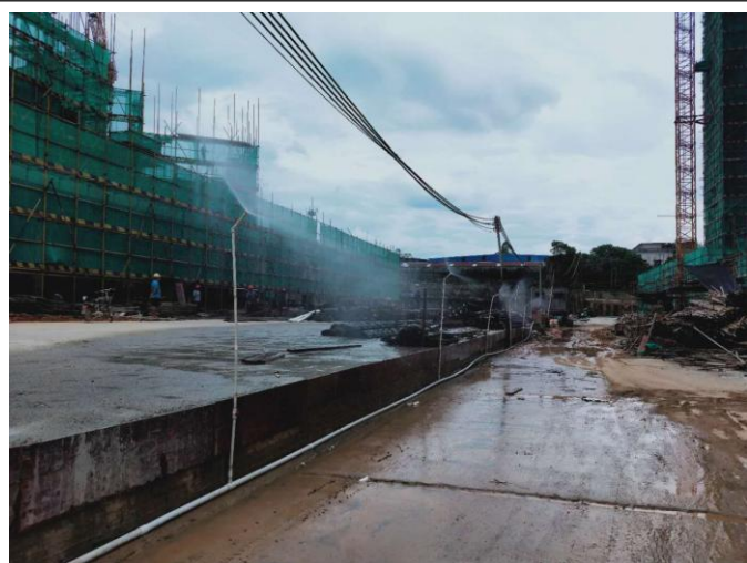
施工期除尘喷雾
