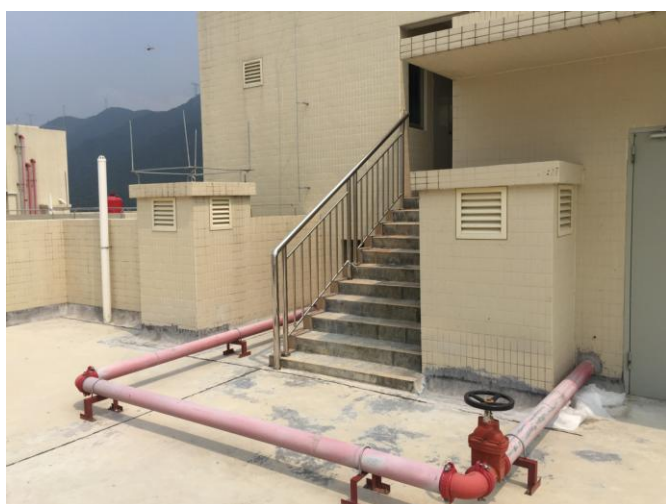
楼顶油烟排放烟囱 2
