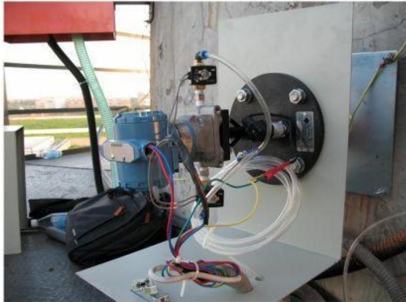
由于皮托管流速计加装了反吹系统，并采用罗斯蒙特 3051CD1 型变送器，所以日常维护量很小
