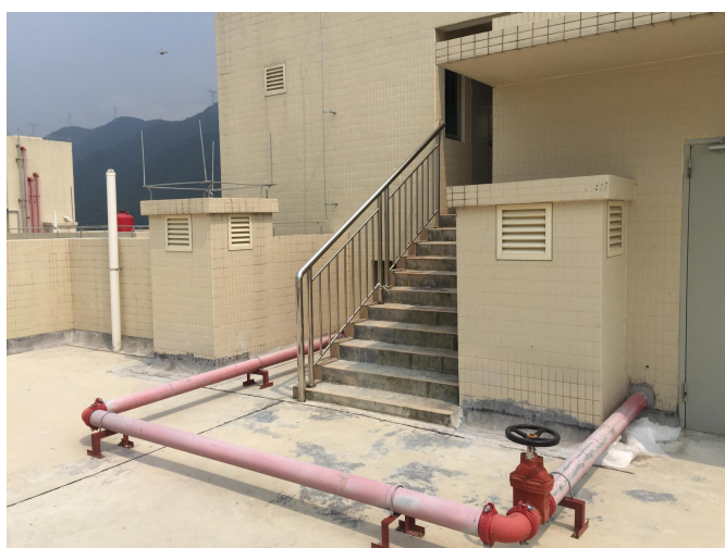
楼顶油烟排放烟囱 2
