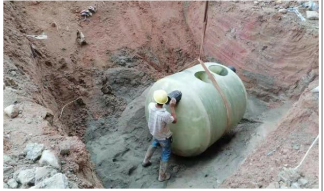
11#楼隔油隔渣池
