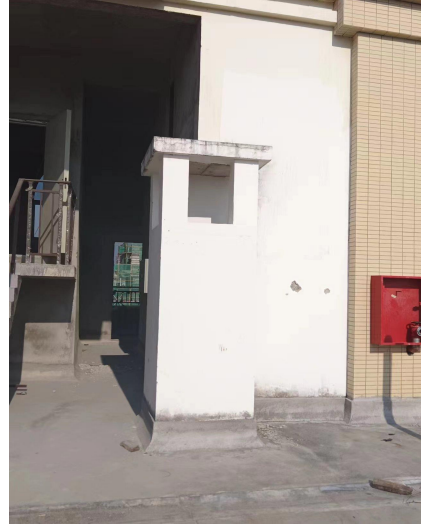
9#楼顶油烟排放烟囱
