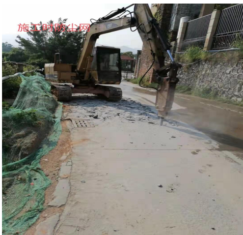
施工时防尘网 1
