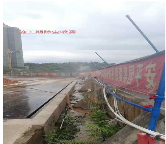
施工期除尘喷雾
