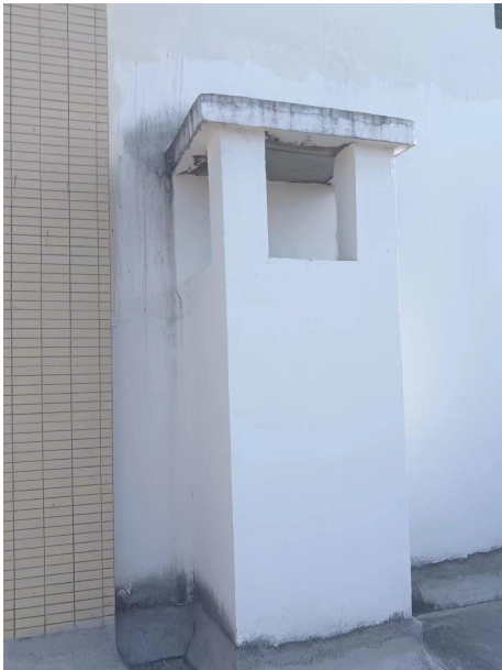
11#楼顶油烟排放烟囱
