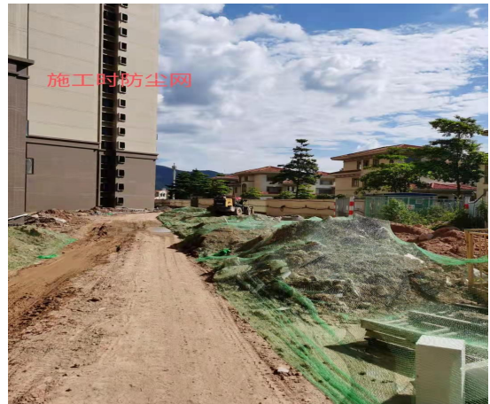
施工时防尘网 2
