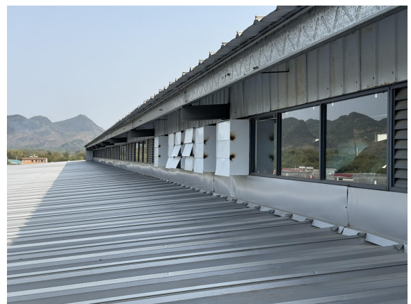
图 3.1-2 本项目废气处理设施现场图和废气排放口
