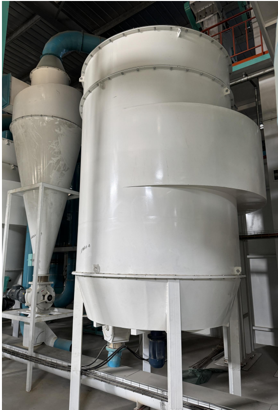
DA001 关风器+脉冲除尘器
