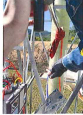
除臭装置排气筒(DA001)
