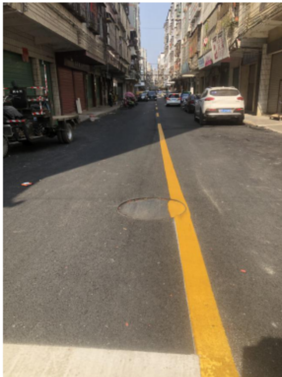
铺设好的污水管道
