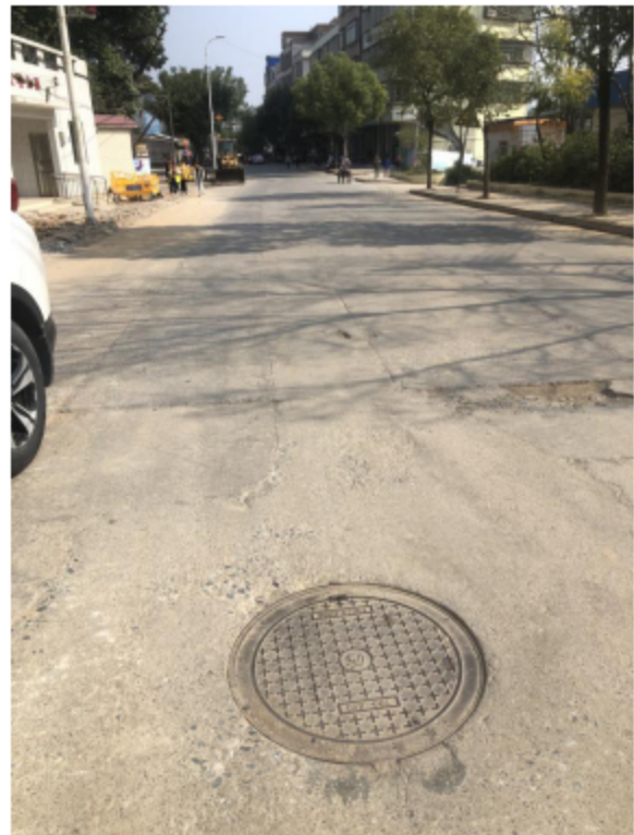
铺设好的污水管道
