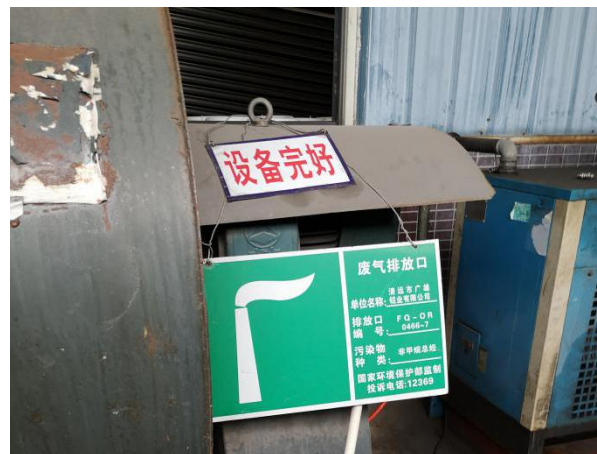
图4.2-2 废气排污口标志牌
