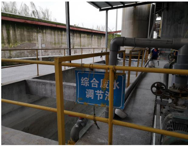
综合废水调节池
