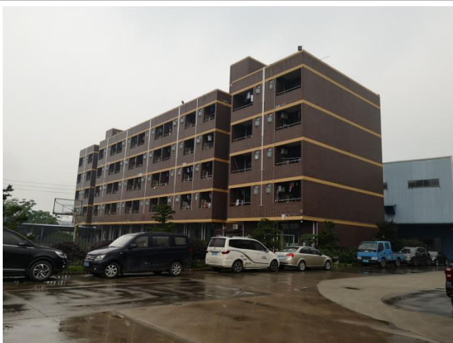
宿舍楼和食堂
