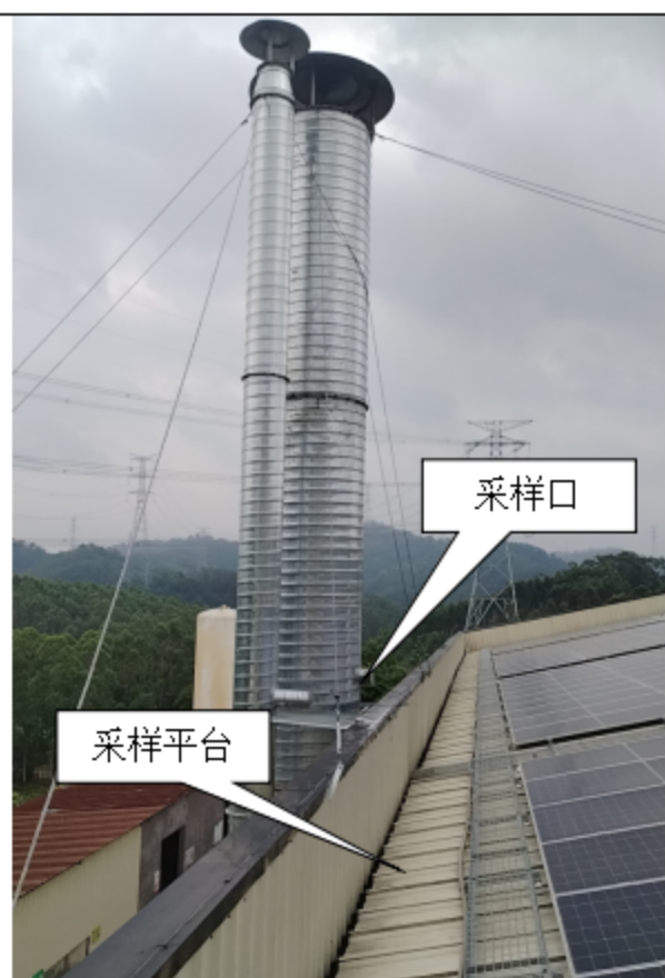
有机废气排放口 (DA002) 采样口
