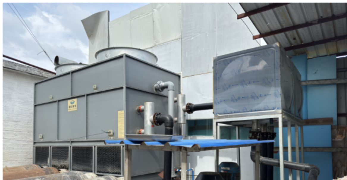
图 3.1-1 冷却水塔
