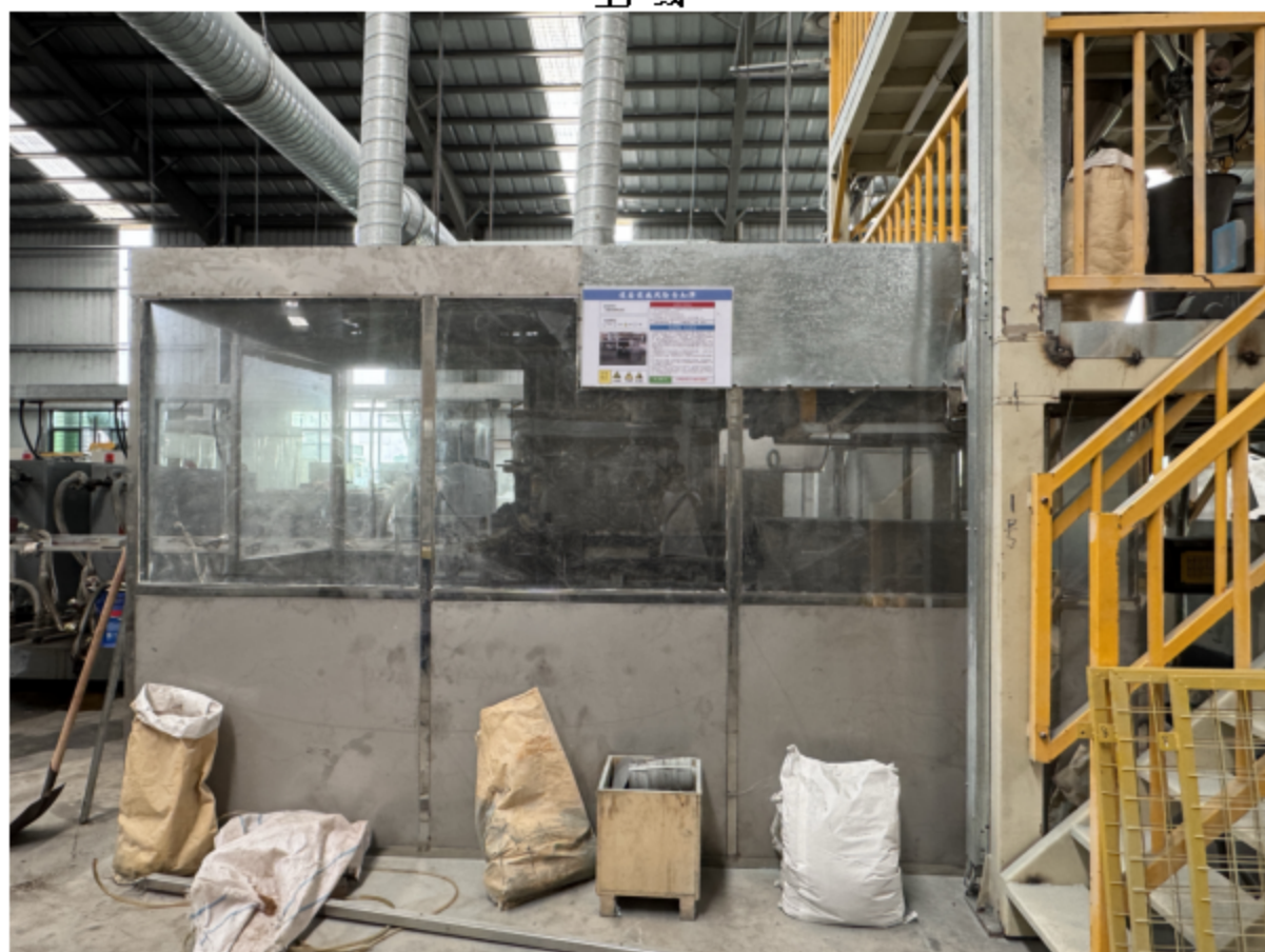
有机废气密闭收集
