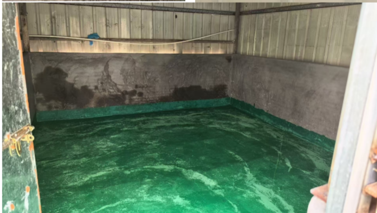
危险废物暂存间
