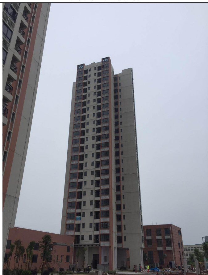
主体工程（1号楼）
