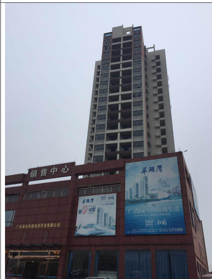
主体工程（商业楼）
