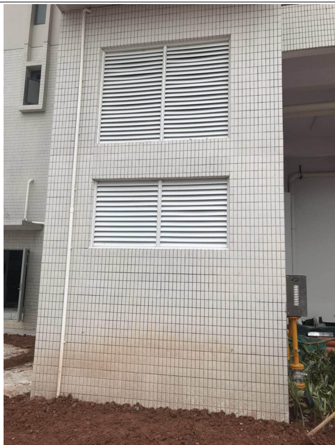
地下室排气口
