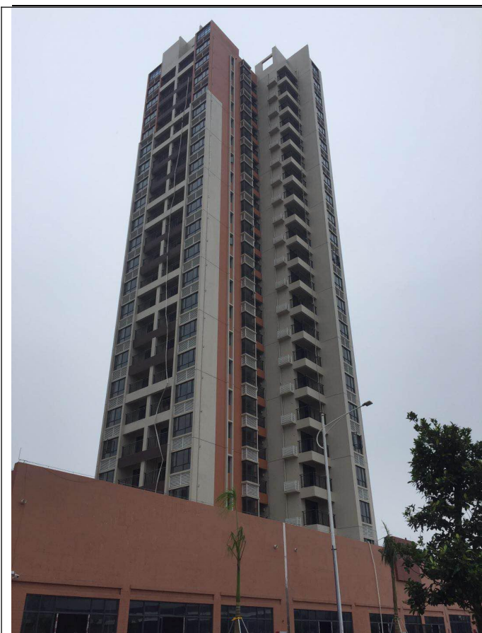
主体工程（2号楼）
