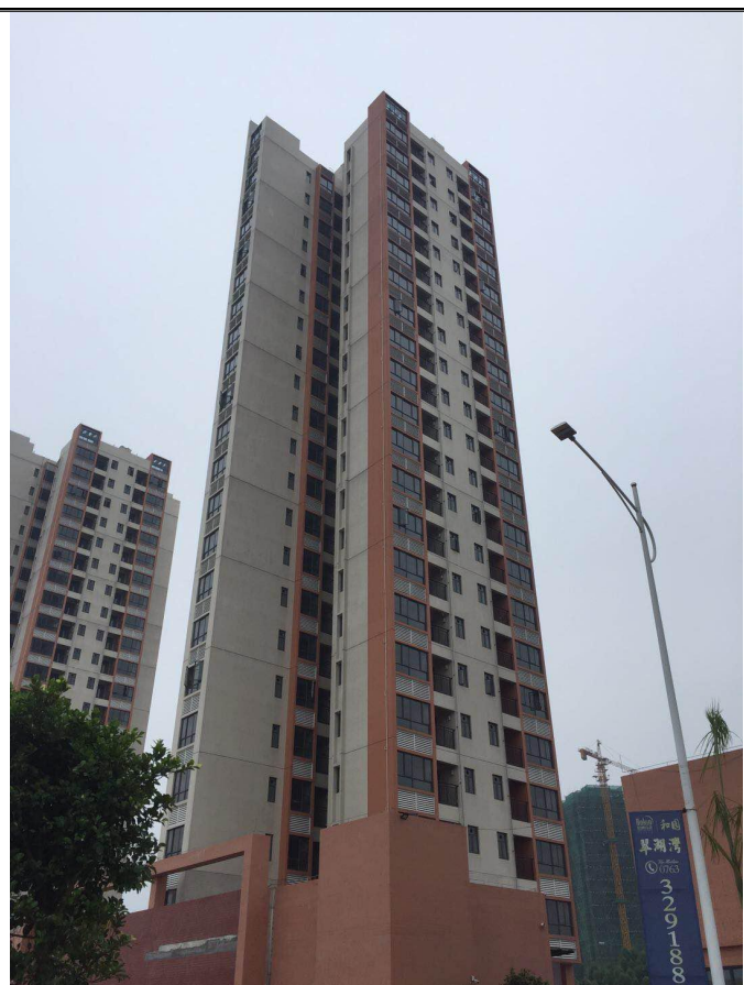
主体工程（3号楼）
