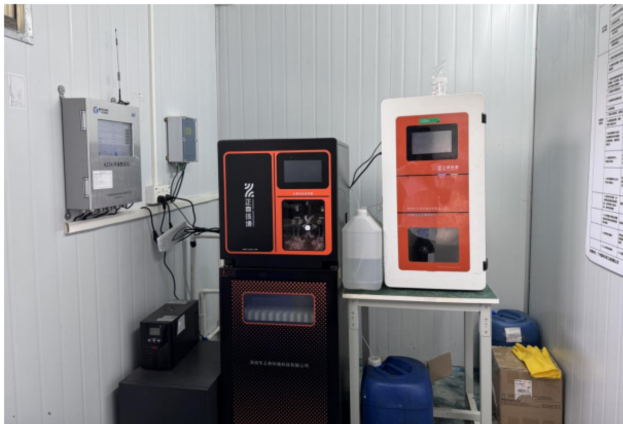
图4.2-2 废水在线监测设备
