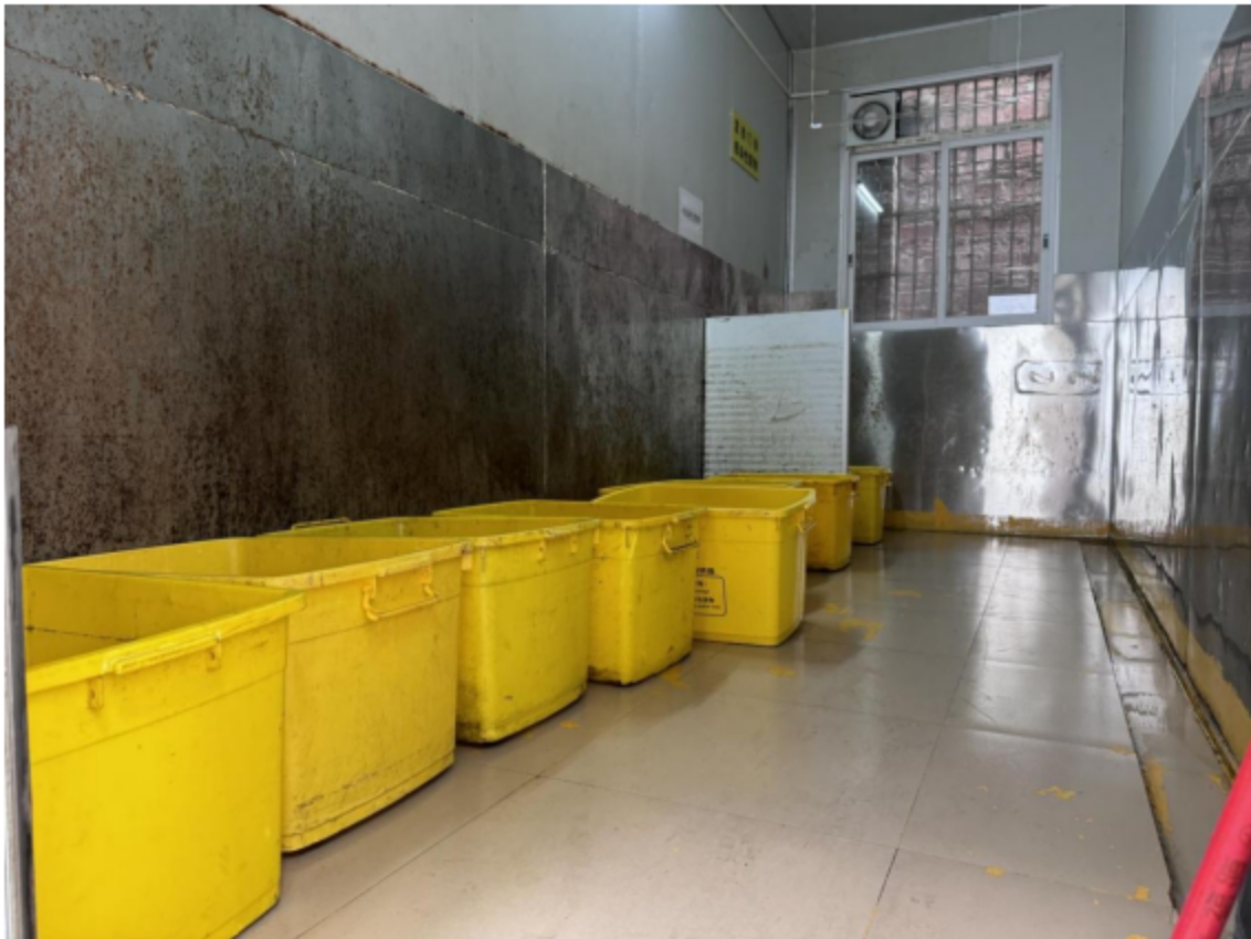
医疗废物暂存间2
