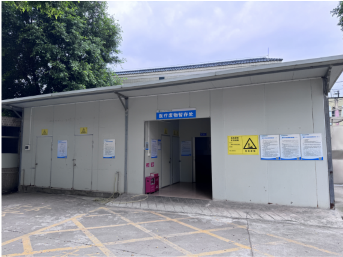
医疗废物暂存间1
