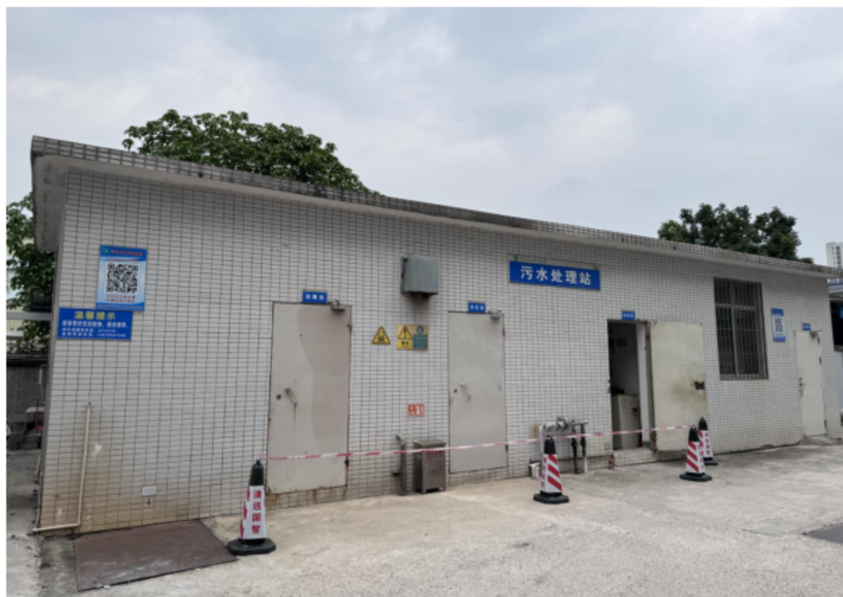
污水处理站（依托）
