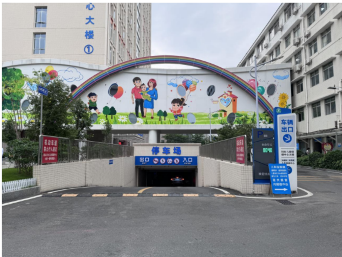
地下车库出入口
