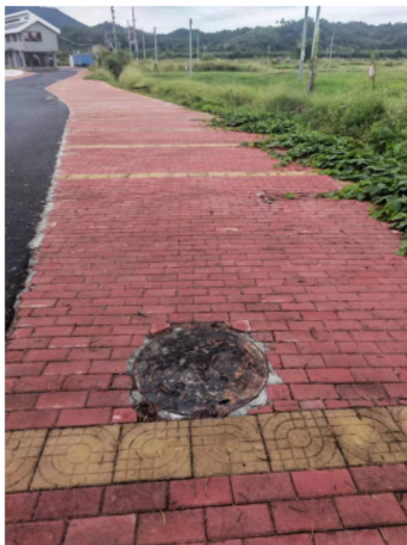
铺设好的污水管道
