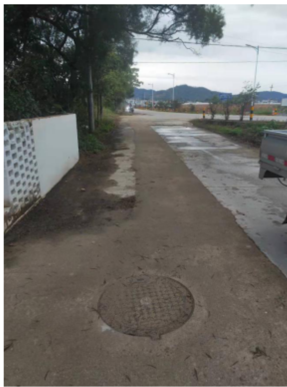
铺设好的污水管道
