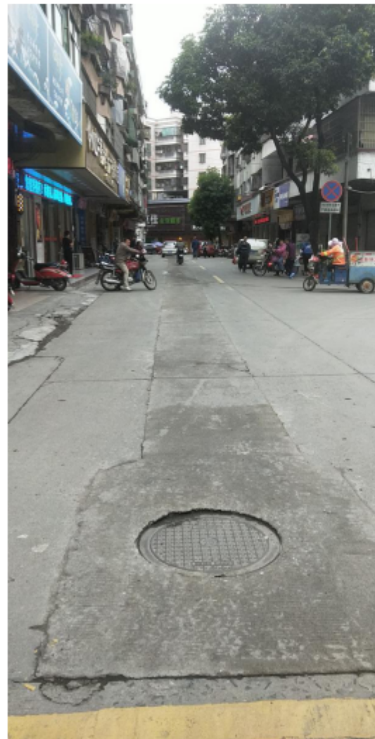
铺设好的污水管道
