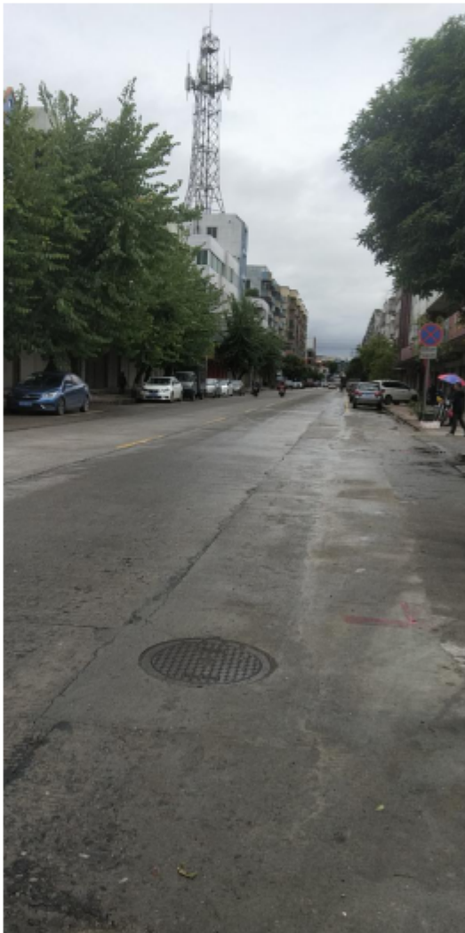
铺设好的污水管道
