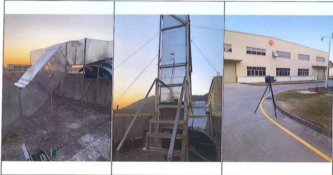
有机废气 G1 排气筒 处理前
