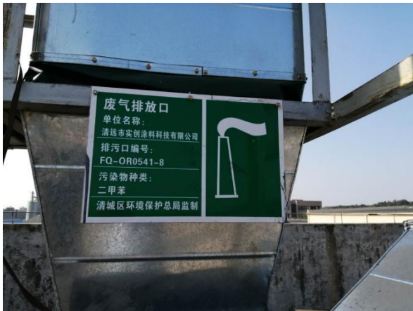
废气排污口标志牌
