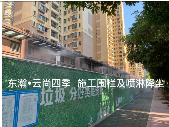
施工围栏及喷淋降尘
